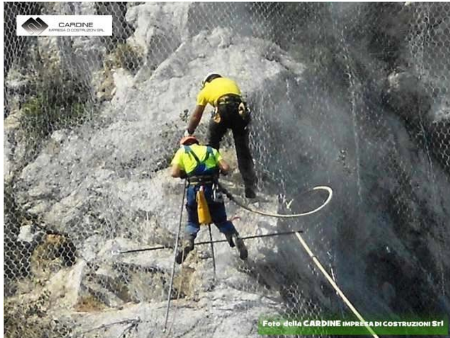
Foto 5, perforazioni di ancoraggio (foto della CARDINE SRL, comune di Conca dei Marini)
