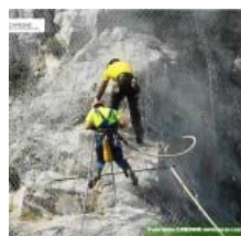
Foto 5, perforazioni di ancoraggio (foto della CARDINE SRL, comune di Conca dei Marini)
