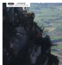
CARDINE COSTRUZIONI SRL, lavori di consolidamento di costoni rocciosi eseguiti in "Costiera Amalfitana"
