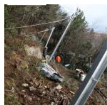
Foto 7, realizzazione barriere paramassi (foto della CARDINE SRL)
