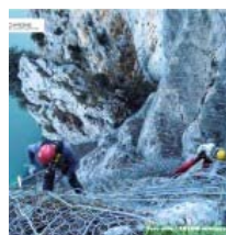
Foto 6, posa in opera di rete in acciaio zincato (foto della CARDINE SRL)
