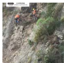
CARDINE COSTRUZIONI SRL, lavori di consolidamento di costoni rocciosi eseguiti in "Costiera Amalfitana"
