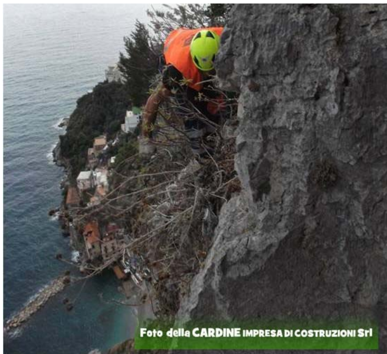
Foto 4, disaggio in cordata (foto della CARDINE SRL, comune di Conca dei Marini)
