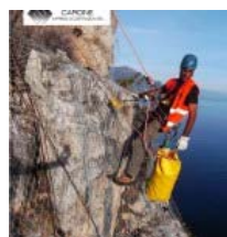
CARDINE COSTRUZIONI SRL, lavori di consolidamento di costoni rocciosi eseguiti in "Costiera Amalfitana"
