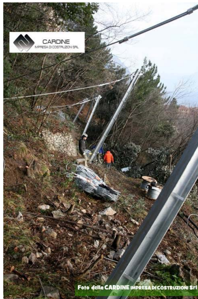
Foto 7, realizzazione barriere paramassi (foto della CARDINE SRL)
