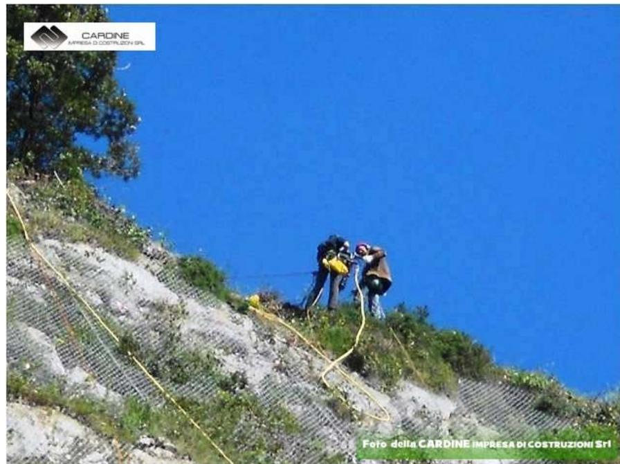
FOTO 5, ancoraggi massi, foto della CARDINE SRL LAVORI IN QUOTA, lavori di consolidamento di costoni rocciosi eseguiti in "Costiera Amalfitana"
