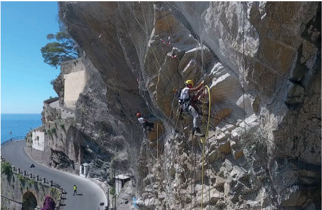
Comune di Minori. Lavorazioni in corda del personale specializzato della ditta acrobatica Cardine srl per la messa in sicurezza del costone sovrastante la grotta dell'Annunziata e sulla SS 163 nel Comune di Maiori
