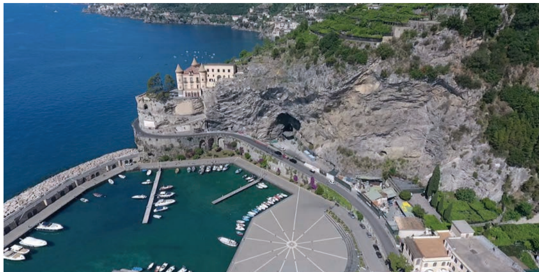
Comune di Maiori. Riprese dal drone della grotta dell'Annunziata, del porto e della SS 163 sulla quale sovrasta il costone roccioso del Comune di Maiori posto in sicurezza
