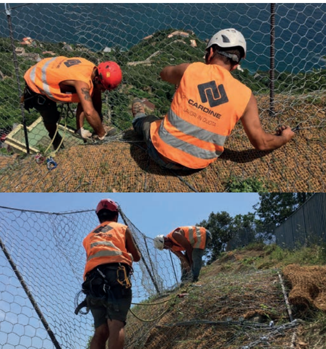
Comune di Ravello. Operai rocciatori specializzati della ditta Cardine srl provvedono alla messa in sicurezza del costone roccioso a ridosso dell'abitato di Minori
