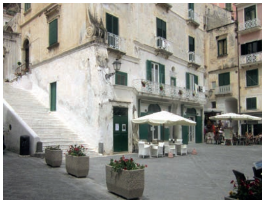
Comune di Atrani, piazza Umberto I (2016). Qui l'acqua e il fango arrivarono al livello della porta posta sulla grande scalinata adiacente via dei Dogi divenuta alveo del torrente Dragone a causa dell'occlusione del passaggio sotto l'arcata del soprastante ponte della SS 163
